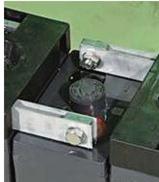
電気的出火危険の検証
